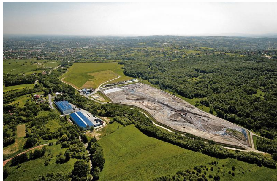
Składowisko odpadów komunalnych Barycz
